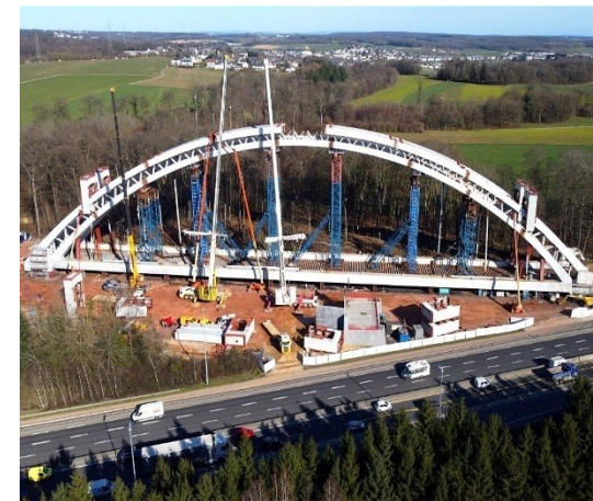
RAILBRIDGE « OA14 » OVER A3 Bettembourg - Luxembourg
