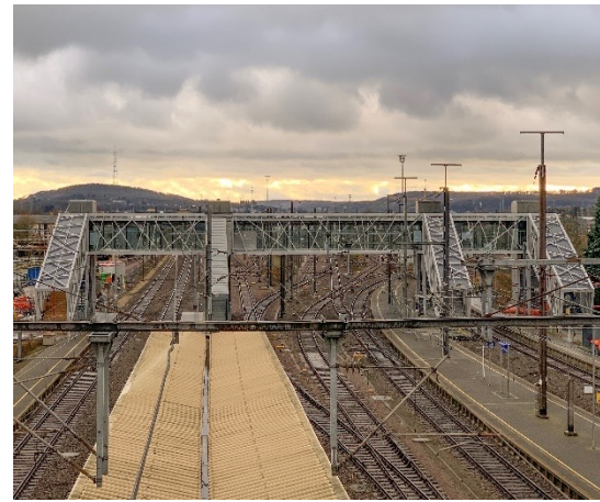
FOOTBRIDGE « PA1 » Bettembourg station
